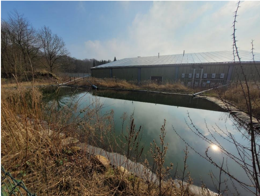
Abbildung 1 (Regenrückhaltebecken & PV Anlage)
