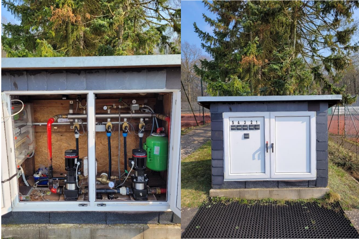
Abbildung 4 & 5 (Platzbewässerungspumpe)
