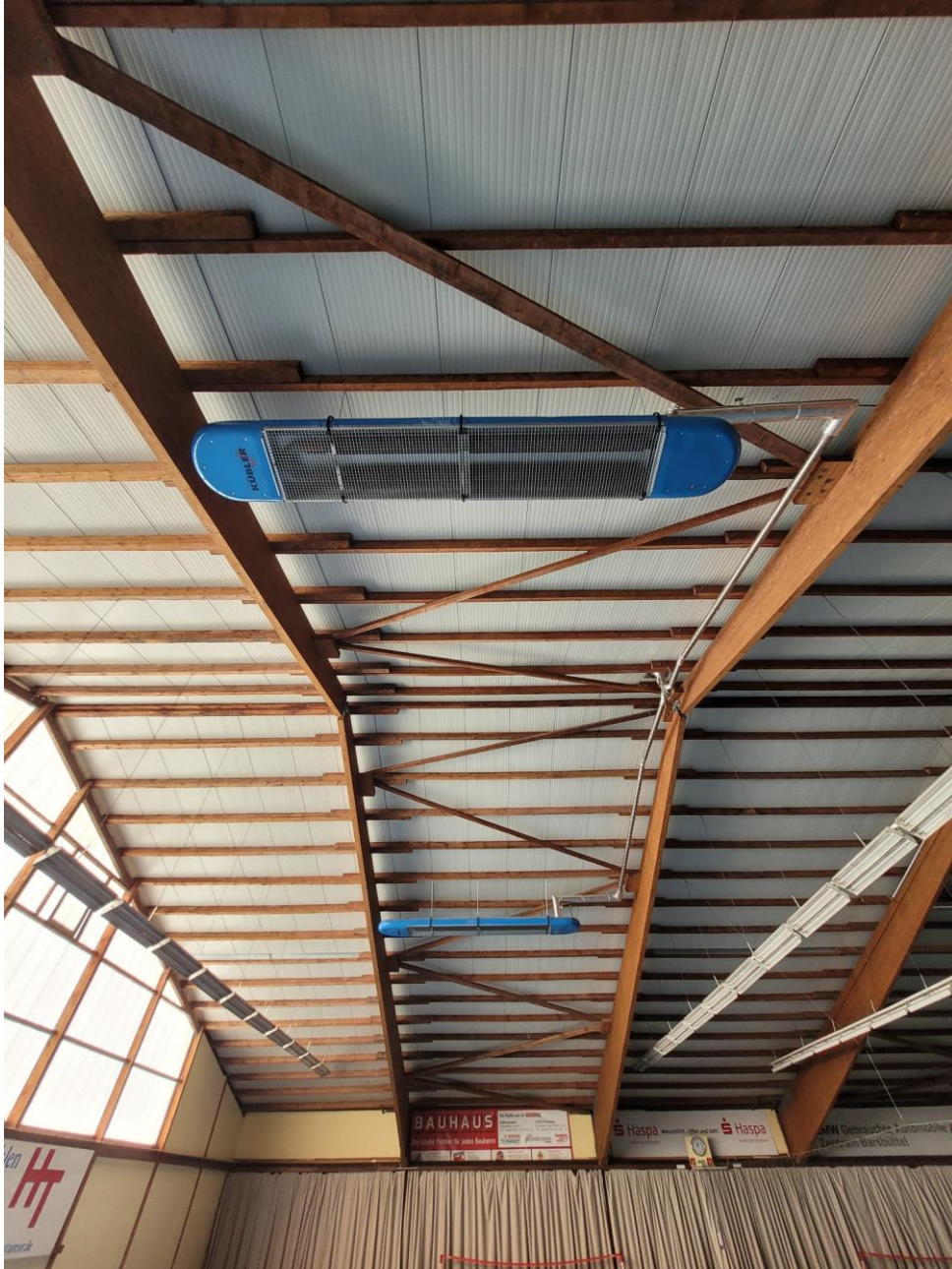
Abbildung 3 (erneuertes Dach mit Platzheizung und LED Beleuchtung)
